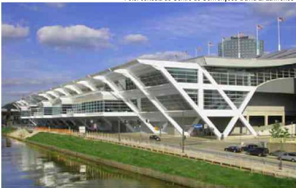
O Centro de Convenções David L. Lawrence em Pittsburgh, Pensilvânia, é o maior edifício “verde” do mundo. Com cerca de 140 mil metros quadrados, as referidas instalações utilizam luz natural e ventilação para iluminação e aquecimento, além de estar equipado com um sistema de reaproveitamento de água que reduz em quase 60% o uso de água potável.
